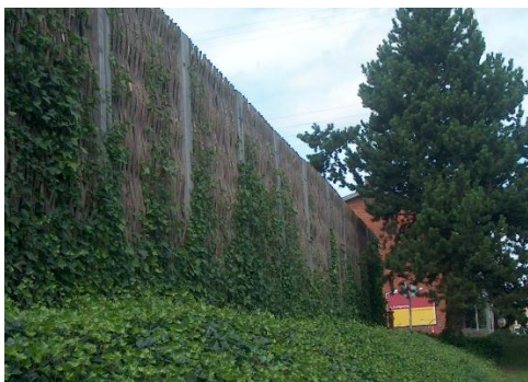
Støjskærm med barket pilefacade og beplantning
