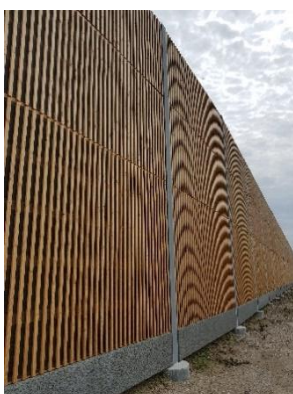
Støjskærm med træbeklædning
