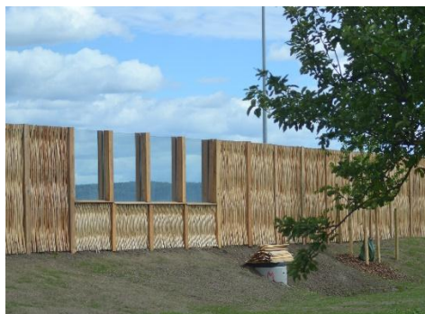
Støjskærm med afbarket pilefacade og transparent felt
