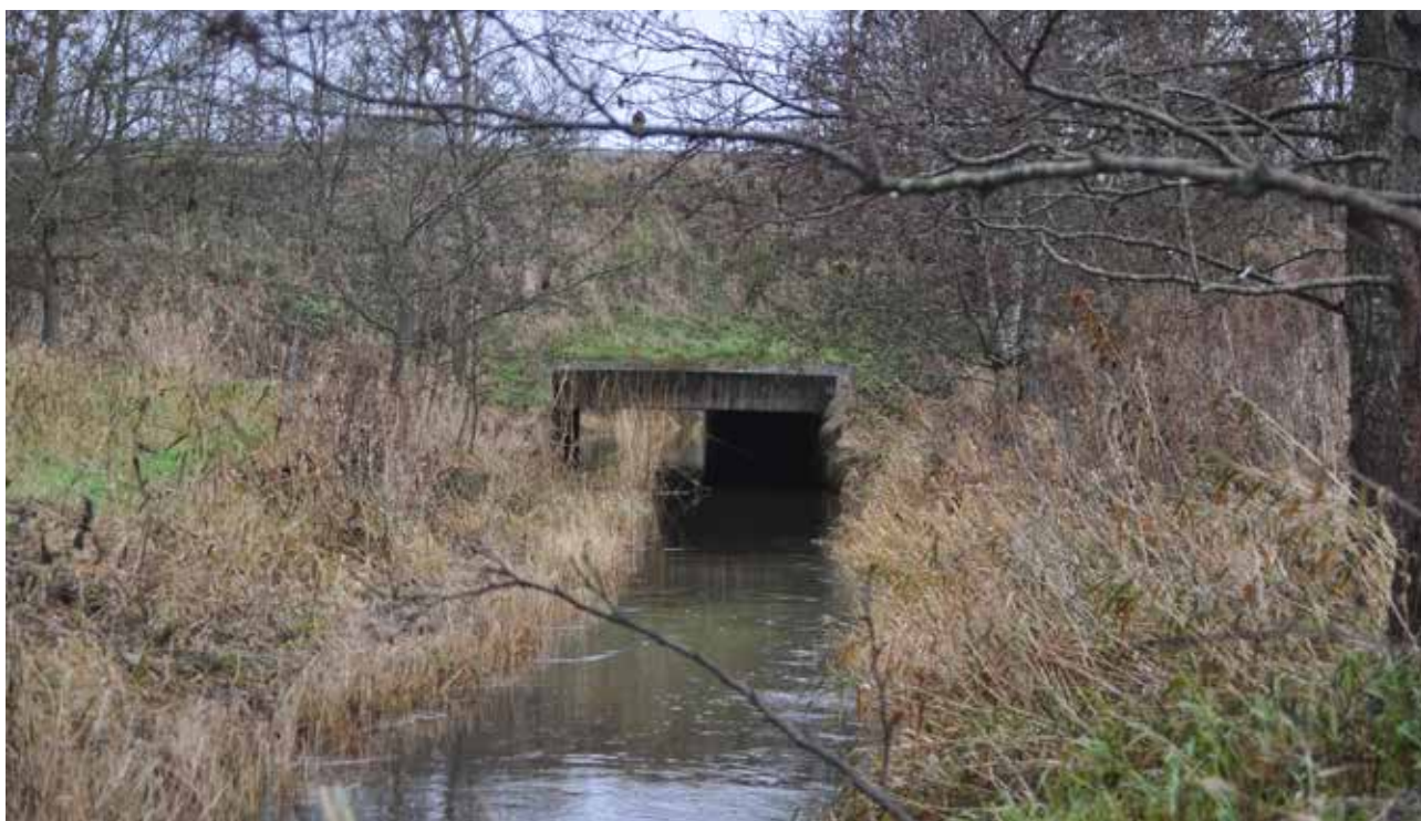
Gremmeløkke Å under Fynske Motorvej.
