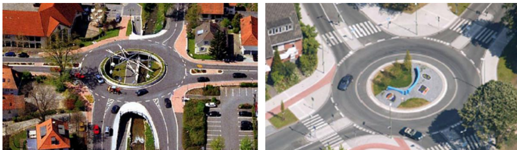
Figur 14. To eksempler på kompakte byrundkørsler i Tyskland (Brilon, 2005).
