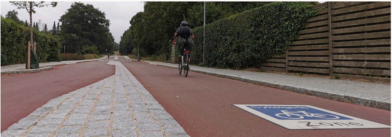
Cykelgade, Højen, Holbæk, med rød belægning og midtervulst. Foto: Holbæk Kommune.
