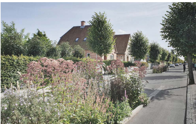
Fartdæmpning tænkt sammen med regnvandsbede i villa-kvarterer i Middelfart. Foto: LYTT Arkitekter.
