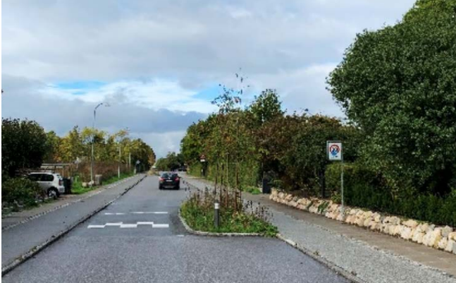
Hævet flade, forsætning og gennemført cykelsti på stillevej med 30 km/t, Kong Hans Allé, Gladsaxe. Foto: Urban Creators.
