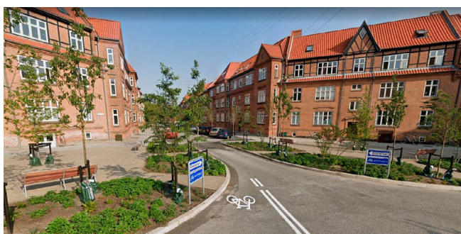
Chr. Kiers Plads (Gerlachsgade/Trepkasgade), Aarhus. Øverst: Oprindeligt krydsdesign. Nederst: Krydset efter indsnævring af kryds og etablering af "hundeeører". Foto: Aarhus Kommune.
