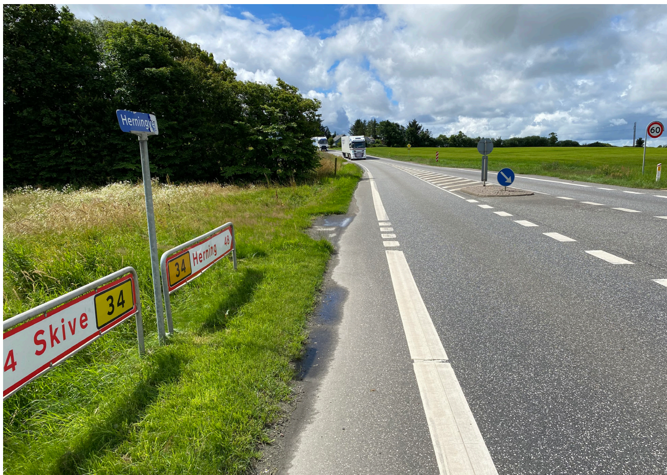
Rute 34: Strækning hvor vejprofilet skal udbygges til 8 meter
